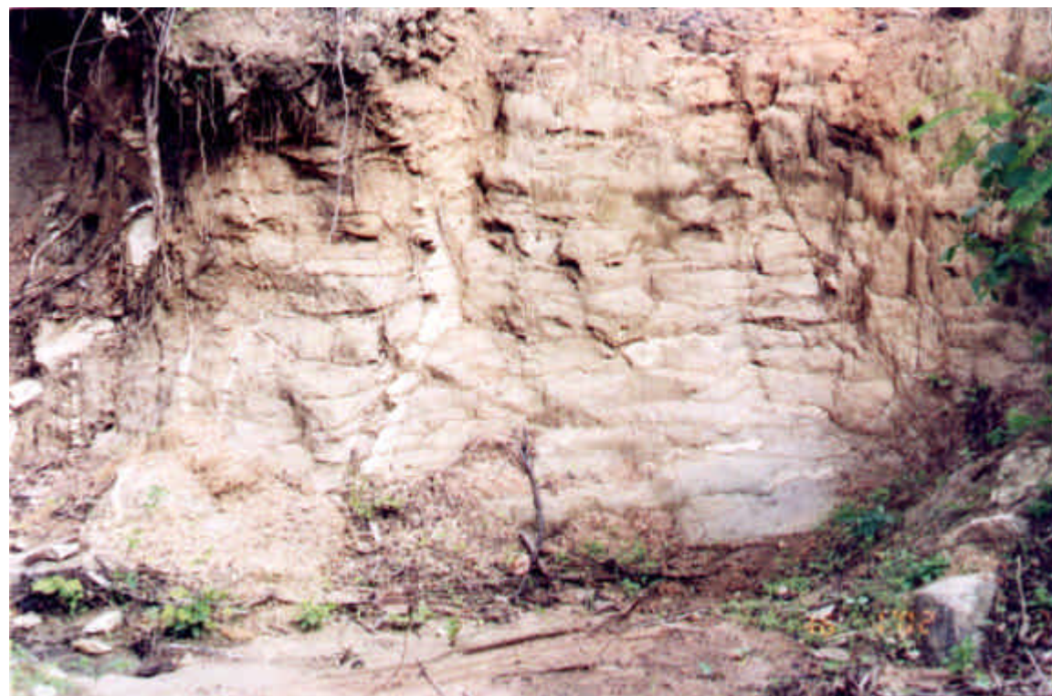
FOTO 02 – AS CONDIÇÕES CLIMÁTICAS DA REGIÃO FAVORECEM SOBREMANEIRA AO INTEMPERISMO DAS LITOLOGIAS. NESTE PERFIL LOCALIZADO NO SETOR SUL DA BACIA HIDRÁULICA, É POSSÍVEL INDIVIDUALIZAR UNICAMENTE OS VEIOS DE QUARTZO, MANCHAS CLARAS, NO MEIO DA MASSA INTEMPERIZADA.
